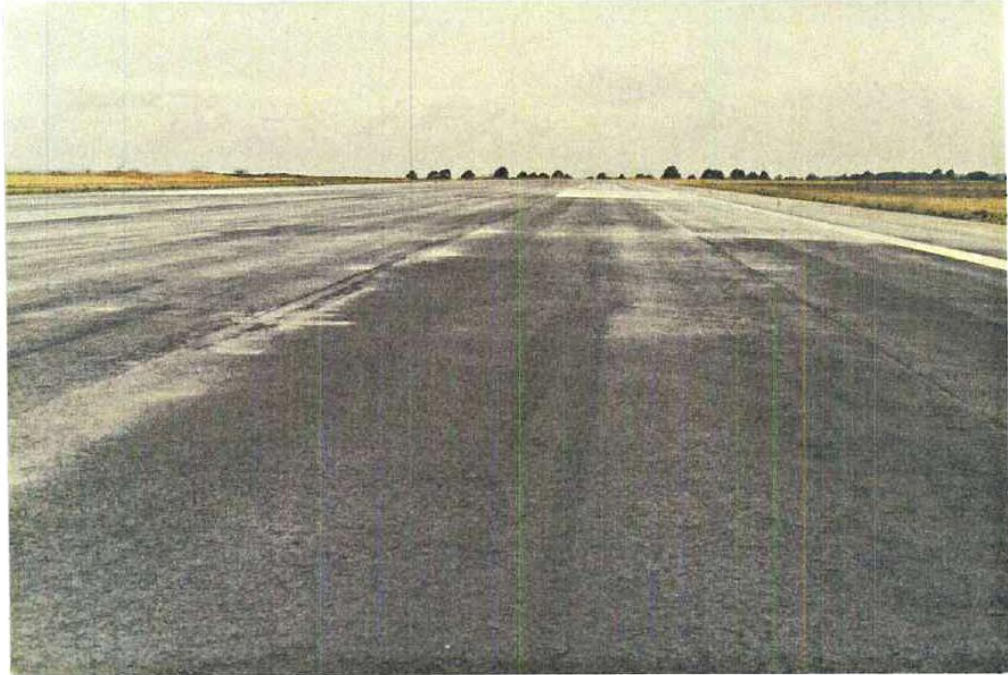
Marcas relevantes dos pneus do trem Principal Direito na Pista 11
